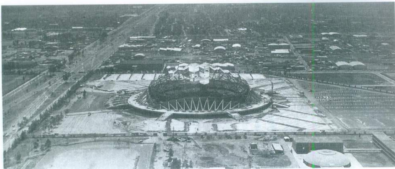
Construcción del Palacio de los Deportes.
