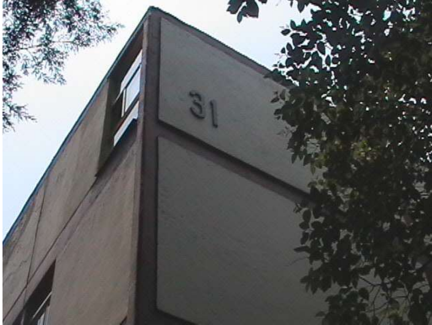
Vista actual del número de identificación del edificio
