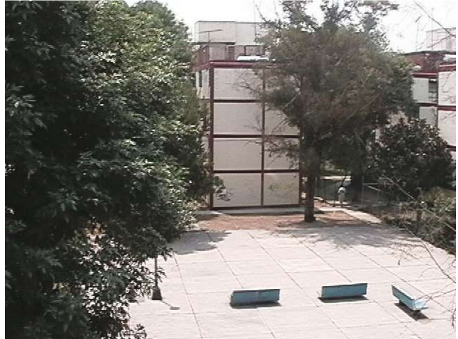
Vista del interior de la sección B.
