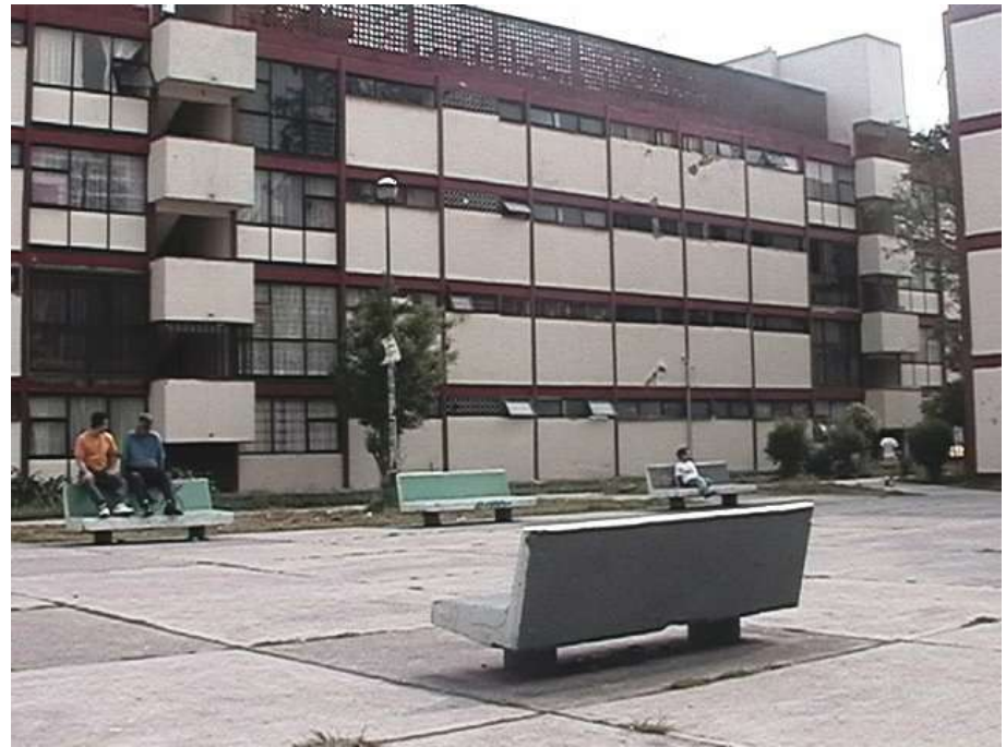
Vista del interior de la sección B.
