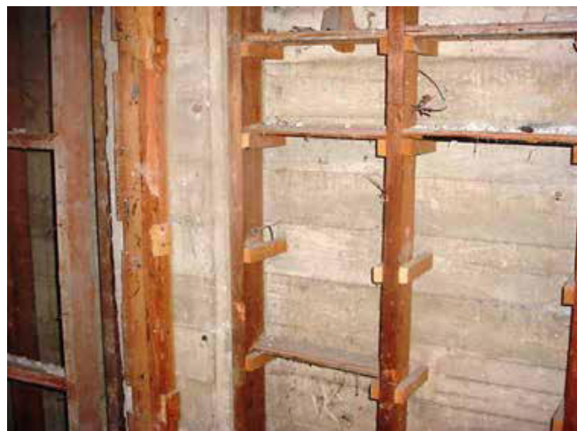
Figura 11. Muro de concreto armado, con bastidor de madera al interior del Palacio de Gobierno Mexicali, B.C. ca. 2009. Actualmente Rectoría de la Universidad Autónoma de Baja California. Fuente. Col. C. Robles.
