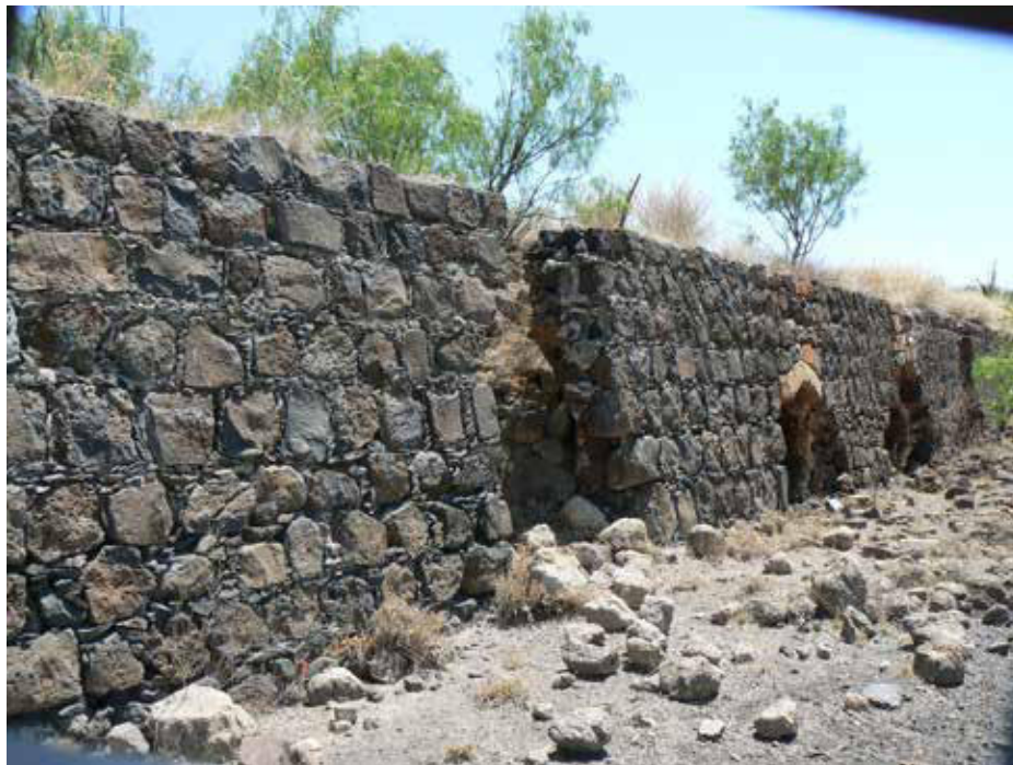
Figura 9. Estructura de hornos de colmena para coque (Coke Behive Oven), en El Hondo. Estas estructuras consistieron en dos partes: una se refiere a todas las piezas de ladrillo, para vanos de puertas y bóvedas, que en algunos casos se fabricaron en San Luis Misuri, y otra parte consiste en el relleno de tierra y obra de mampostería exterior. La gente en la región ha saqueado estos materiales para resolver sus necesidades de habitación. Fotografía del autor (2009).
