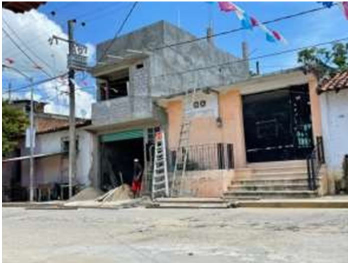
Fotografía 4 Vivienda minada por la sombra de la modernización
