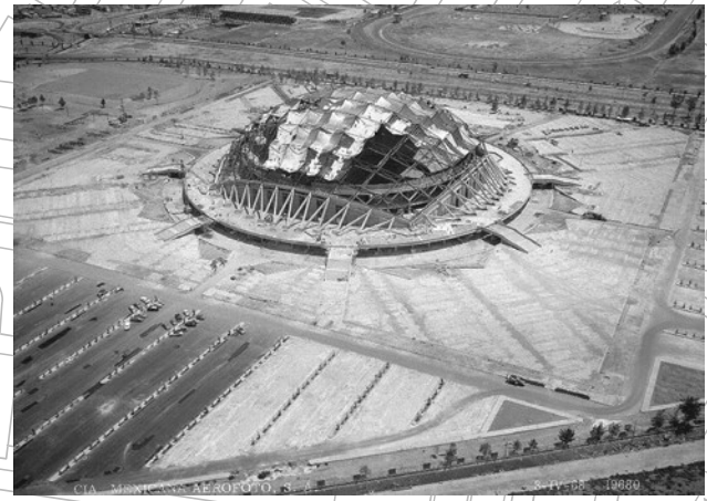
Construcción del Palacio de los Deportes, 1968. Acervo Histórico de Fundación ICA.
