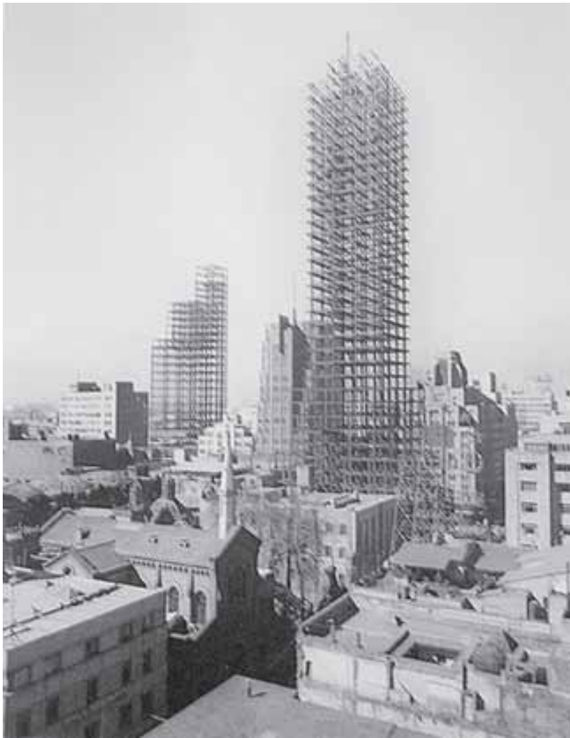
Estructura de hierro para la construcción de la Torre Latinoamericana.
