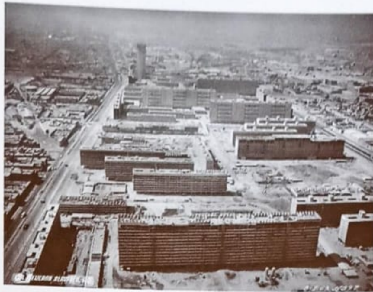
Construcción de Nonoalco.
