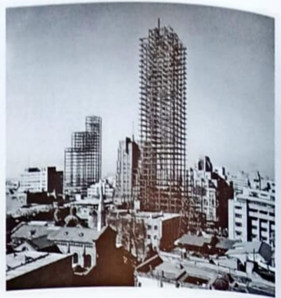
Construcción de la Torre latinoamericana, 1949. fuente: https://mxcity.mx/2018/12/torre-latinoamericana-nuevas-atracciones-plataforma-de-cristal/
