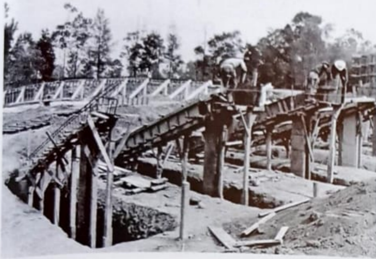
Construcción del Estadio Olímpico.
