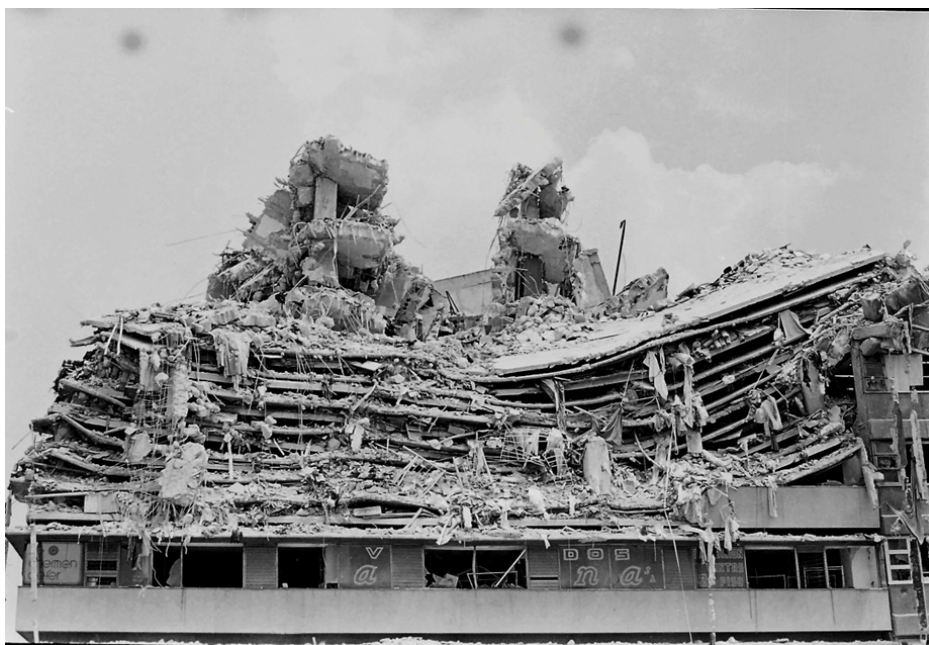
Figura 4. Derrumbes por el sismo de 1985. San Antonio Abad y Pino Suarez. Octubre de 1985. Fuente: ©Gobierno de la Ciudad de México, Secretaría de Cultura, Museo Archivo de la Fotografía.
