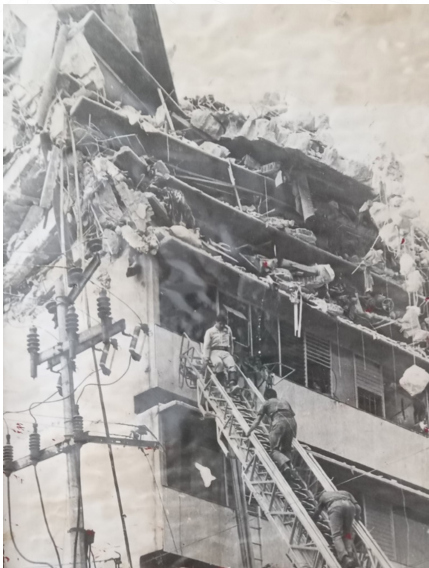
Figura 1. Edificio con talleres de costura en San Antonio Abad, afectado por el sismo de 1985. Fuente: Sinueh Días. Acervo histórico de la Asociación de Costureras y Costureros 19 de septiembre A.C.
