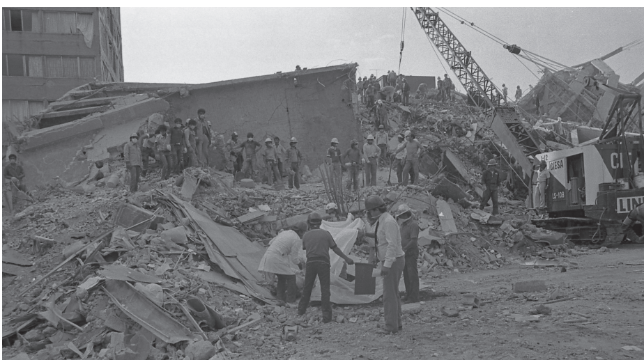
Figura 10. Edificios dañados en el centro de la ciudad de México, septiembre 19 de 1985. Fuente: ©Gobierno de la Ciudad de México, Secretaría de Cultura, Museo Archivo de la Fotografía.
