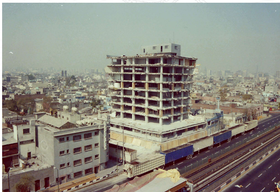
Figura 7. Demolición del Edificio de la Dirección General de Obras Hidráulicas del D.F., en Calzada de Tlalpan, diciembre 08, 1985. Fuente: ©Gobierno de la Ciudad de México, Secretaría de Cultura, Museo Archivo de la Fotografía.
