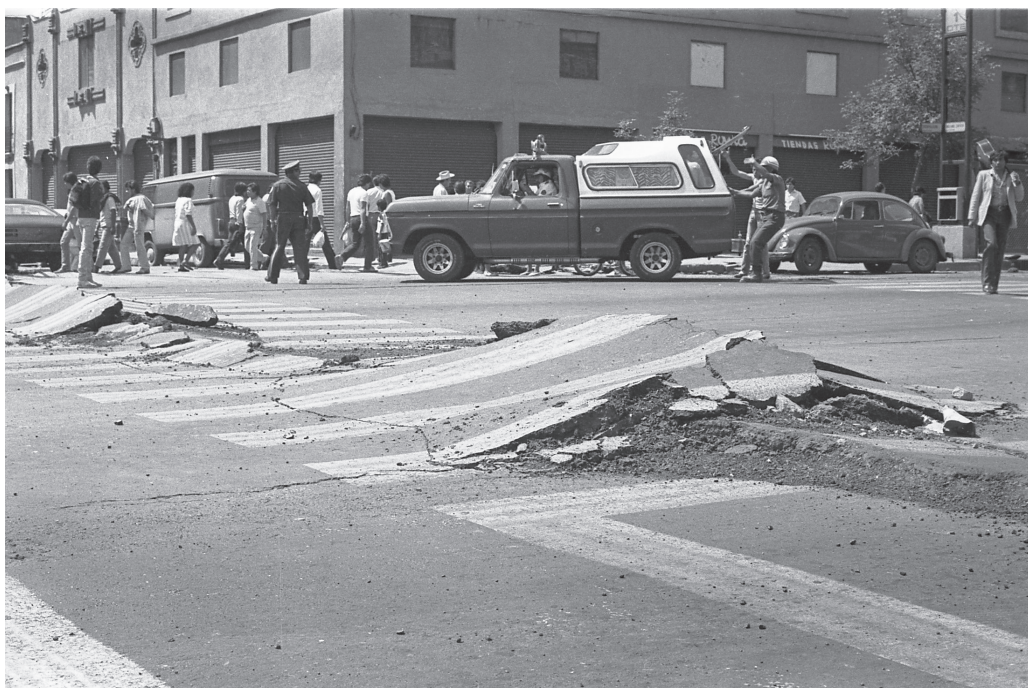
Figura 8. Las vías de comunicación interrumpidas por el rompimiento de la carpeta asfáltica debido al sismo de 1985, en la Ciudad de México. Fuente: ©Gobierno de la Ciudad de México, Secretaría de Cultura, Museo Archivo de la Fotografía.
